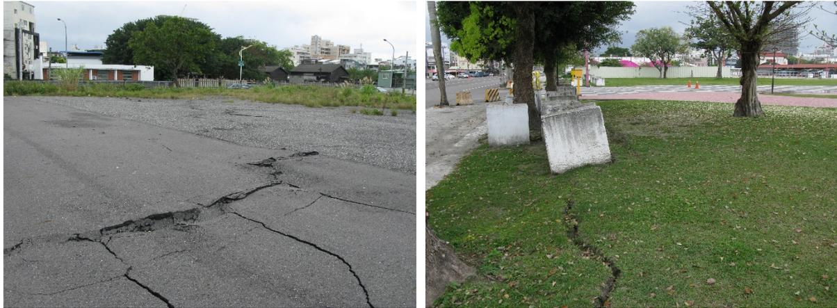
圖 4-3、2018 年 2 月 6 日花蓮地震地表破裂。破裂具左移及東側抬升現象，左圖位於廣東街與博愛街口東側空地，照片向北拍攝；右圖位於花蓮東大門夜市西南角鄰近自由街處，照片向西北拍攝。
