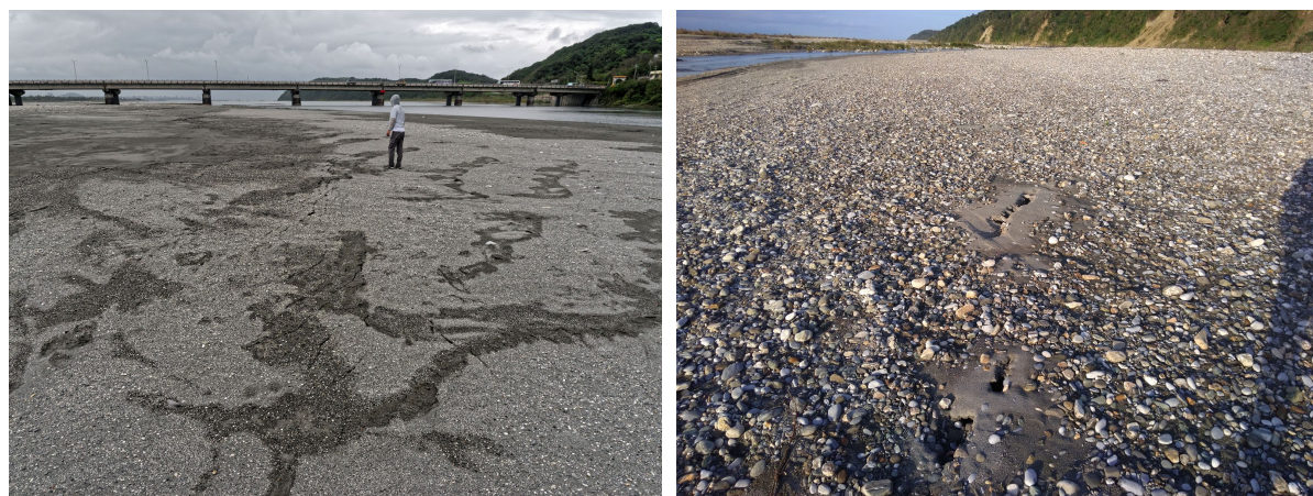
圖 4-8、2018 年 2 月 6 日花蓮地震嶺頂斷層沿線出現的地表破裂（劉彥求攝）。照片均為向北拍攝，左圖攝於花蓮大橋南側，右圖攝於木瓜溪與花蓮溪匯流處南側。
