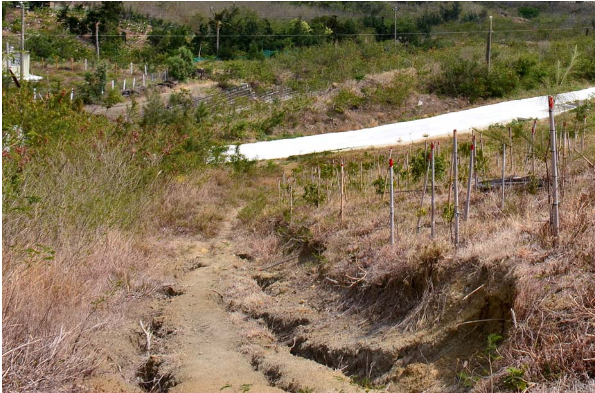
照片 13 周邊緩坡處局部可見墾丁層泥岩受蝕後形成的沖蝕溝。照片向南拍攝，攝於 107 年 5 月 21 日。
