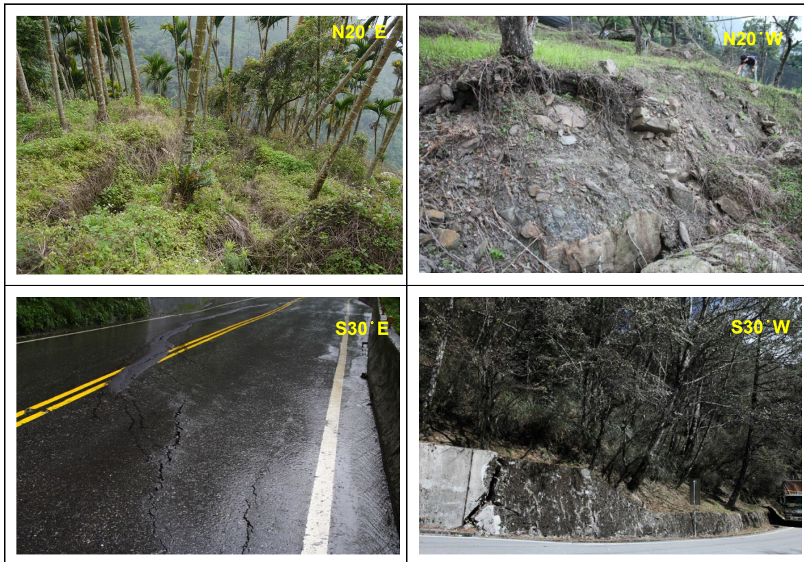
圖 5-4 常見的地表變形現象，係潛在山崩與地滑之徵兆。左上：小崩崖與樹木傾倒；右上：崩崖；左下：張力裂縫發育漸造成道路陷落；右下：擋土牆破壞外推。
