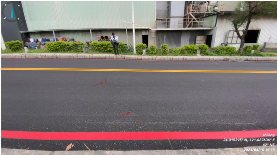
圖 23、地震力造成柏油路破壞現象，紅色箭頭處（向東北拍攝）。
