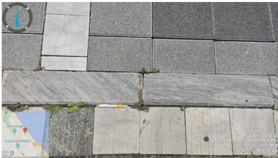
圖 12、七星潭地區因受地震力搖晃而產生的局部噴沙現象。（黃志遠拍攝）
