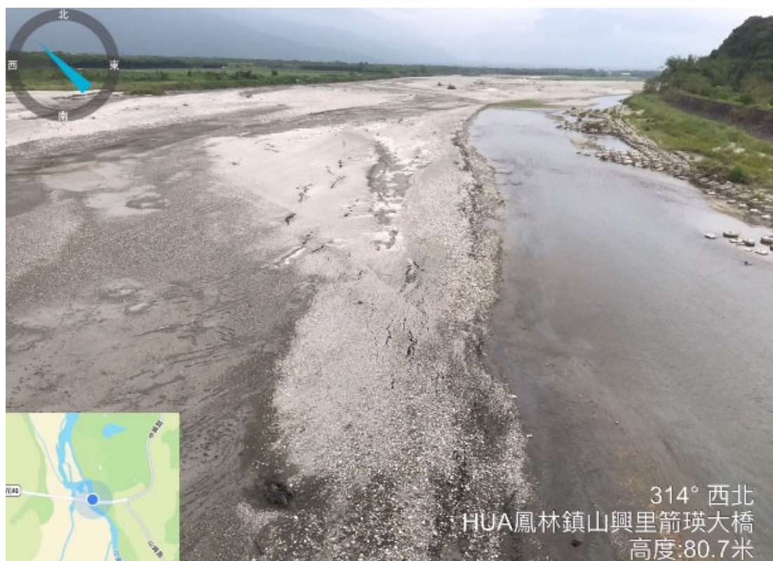
圖 19、箭瑛大橋鳥瞰沙洲側潰與噴沙現象（向西北拍攝）。（陳盈璇拍攝）
