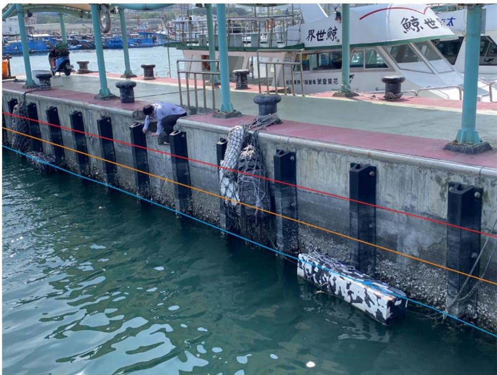
圖 24、花蓮港區藤壺與牡蠣等潮間帶生物被抬離水面。紅線為地震前潮水最高水位線，橘線為地震前潮間帶生物生長最上限，藍線為觀察日（4月17日）滿潮最高水位線。（梁勝雄拍攝）
