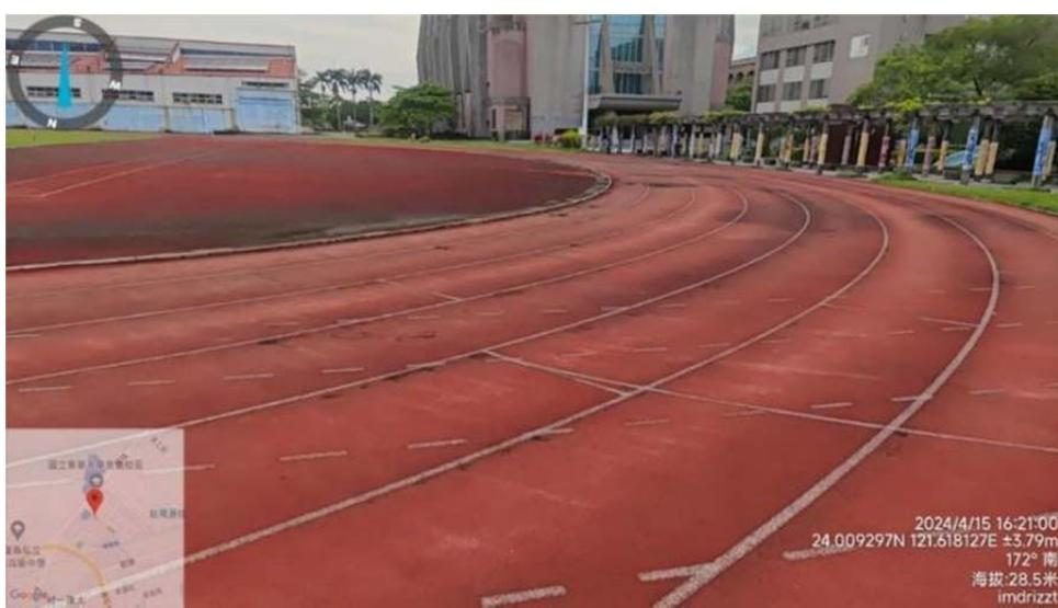
圖 13、東華大學創新園區操場於 2018 地震時受米崙斷層錯動，此次地震未再發生地表破裂現象。（黃志遠拍攝）
