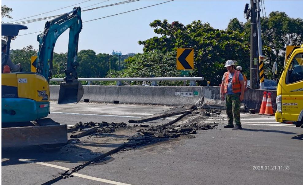
圖 8、玉井區竹圍橋在此次地震受損，照片（向西拍攝）展示竹圍橋北端伸縮縫破裂，橋體相對抬升約 2~4 公分。
