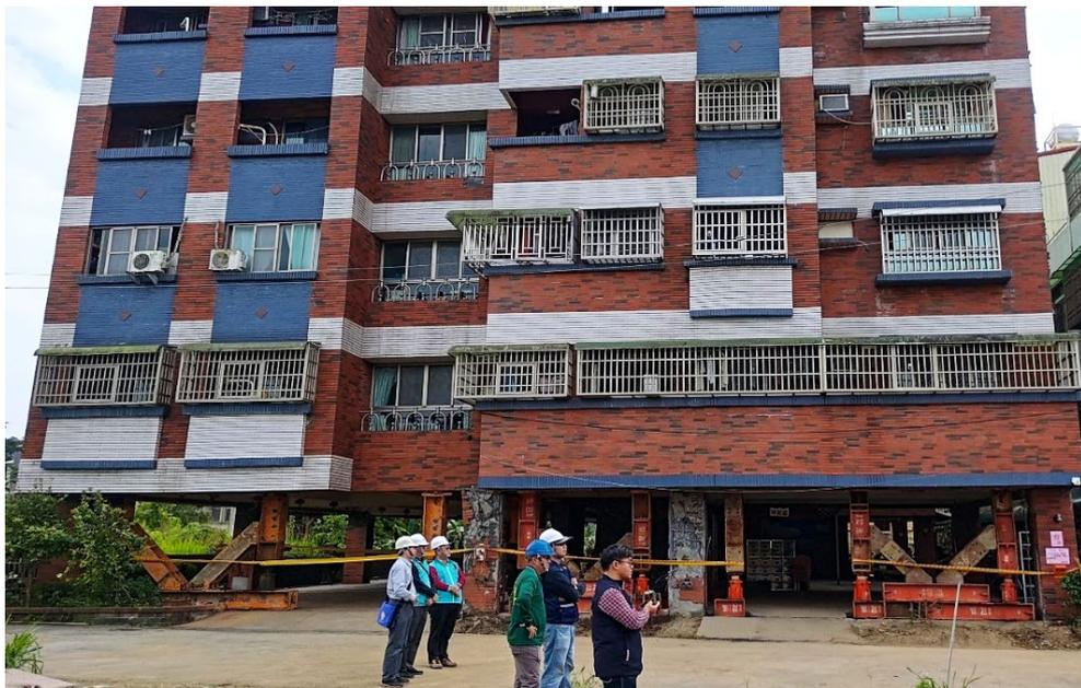
圖 9、玉井區文化大廈在主震後樑柱受損，週遭並無顯著地表破裂，推測由強烈的地振動造成建物損壞。
