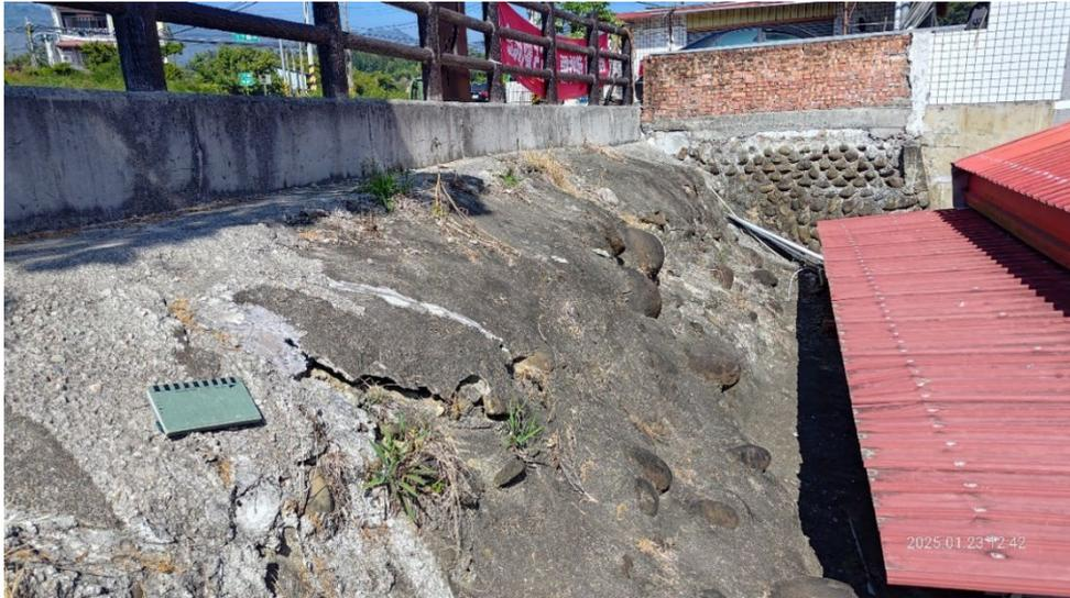
圖 13、楠西區興南口宵里斷層線形崖上，可見廣場旁護坡破裂，上邊坡有向東位移跡象（向北拍攝）。
