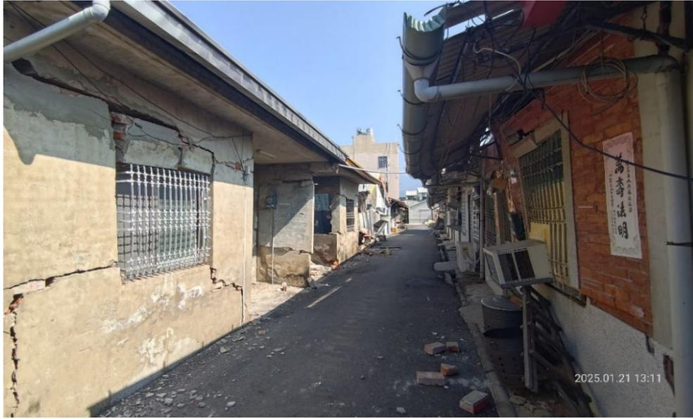
圖 10、楠西區民權、民族與中興路一帶有大量房舍倒塌或破損。在此區未發現顯著的地表破裂，研判災損為地振動引起。
