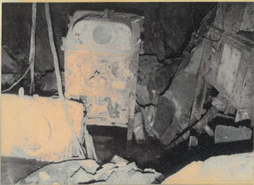
照片十一 220V 50HP 壓風機油控制開關 (O.C.S.)
