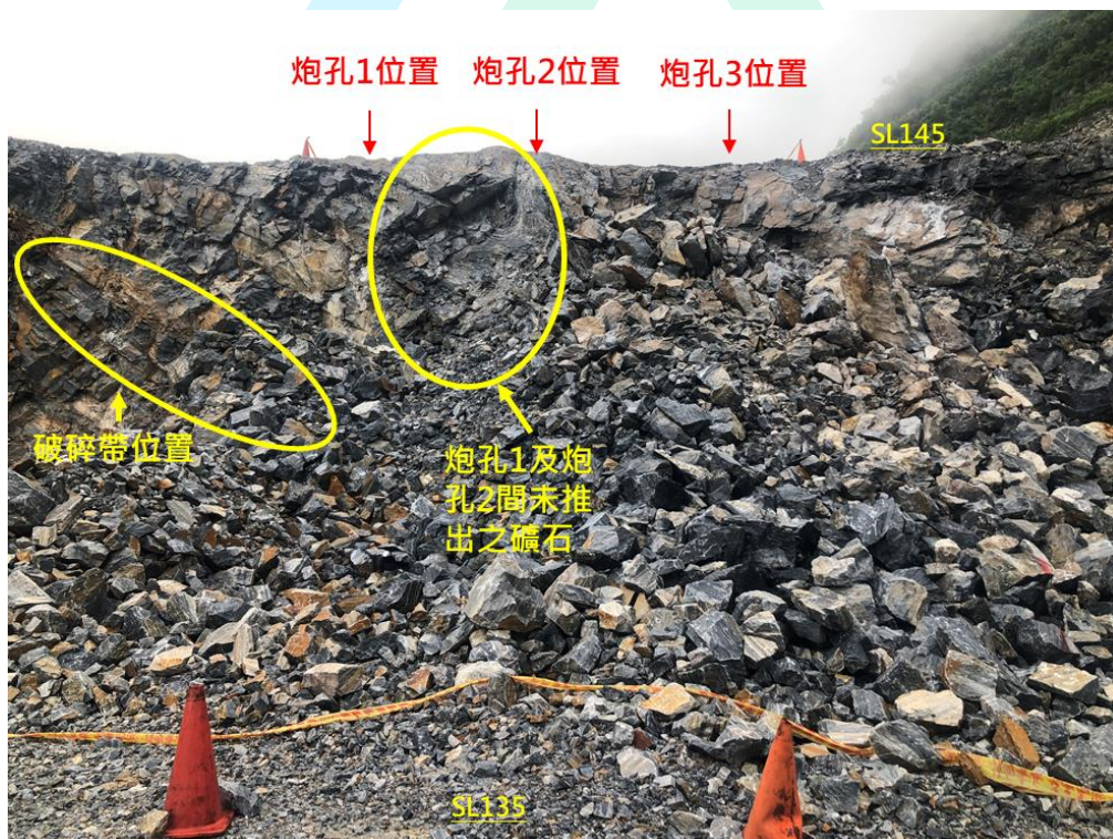
圖 15、事件 145 作業工區之爆破作業後階段自由面與岩層破碎帶位置現況（114.6.13 攝）
