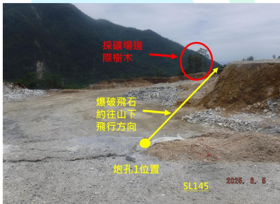
圖 3、炮孔 1 產生之爆破飛石約略飛向方向（114.6.5 攝）
