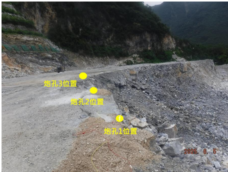
圖 2、145 作業工區上層處（高程 145 公尺）3 處炮孔約略位置（114.6.5 攝）
