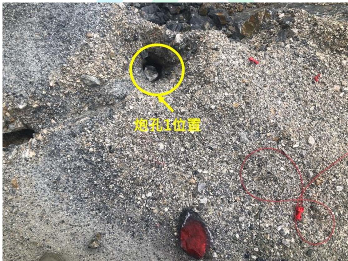
圖 11、近照炮孔 1 殘留 145 作業工區上層處之痕跡 (114.6.13 攝)
