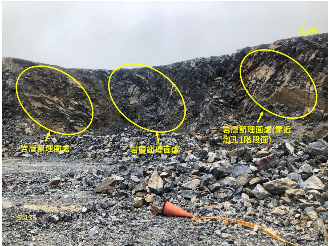
圖 14、事件 145 作業工區左側之爆破作業後階段自由面情形（114.6.13 攝）
